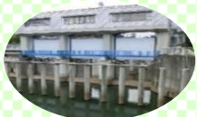
帷子川分水路
